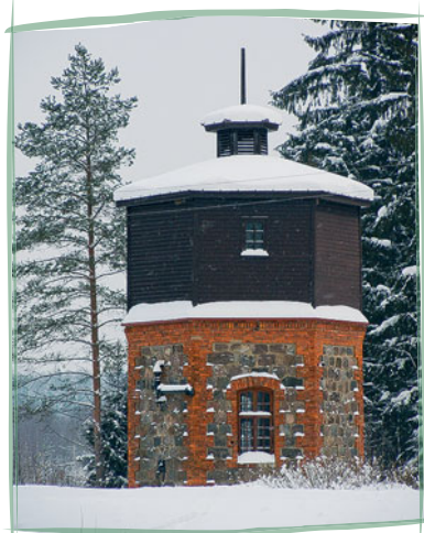
Papardes stacijas ūdenstornis
