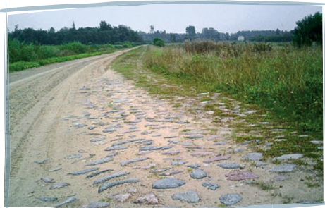
Ipiķu akmens bruģa ceļš
